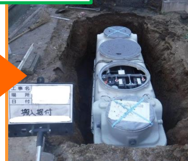
合併浄化槽設置
