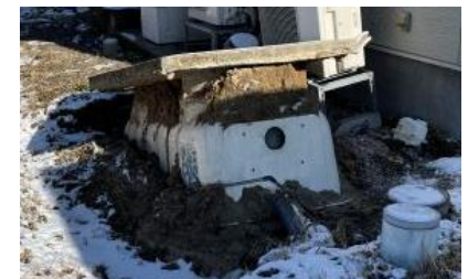
地震により浮き上がった浄化槽 （画像は七尾市内の例）
