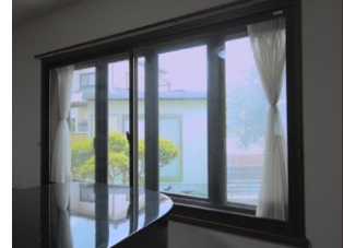
内窓設置を実施
