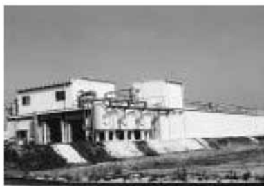
▲排水処理施設
