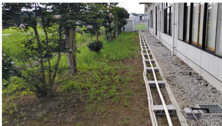
図 4-2-9 温浴施設内湯船への温水送水配管設置状況
