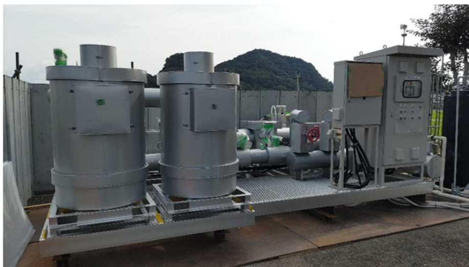
図 4-2-6 放熱設備主要部設置状況写真
