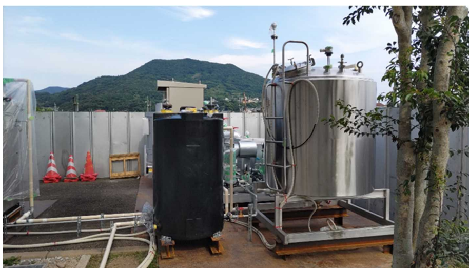
図 4-2-8 貯湯槽設置状況
