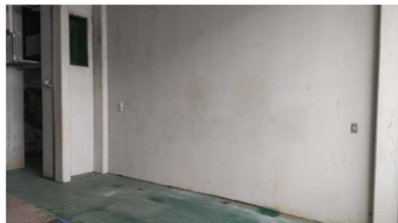
図 5-5-2 蓄熱ユニット撤去後
