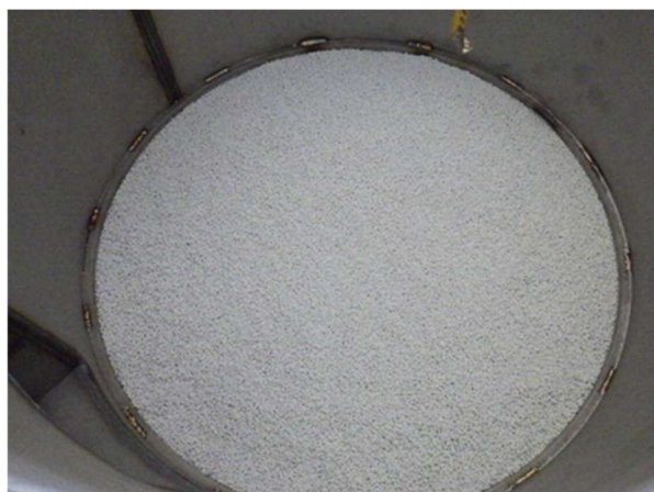
図 5-1-4 蓄熱材充填状況
