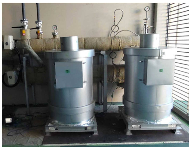
図 4-1-8 反応器取付け後の状況
