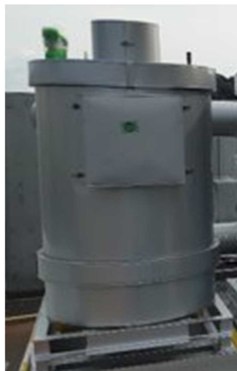
図 5-1-5 蓄熱材の反応器への充填状況
