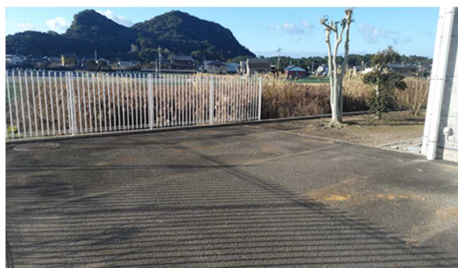
図 5-5-3 放熱設備撤去後
