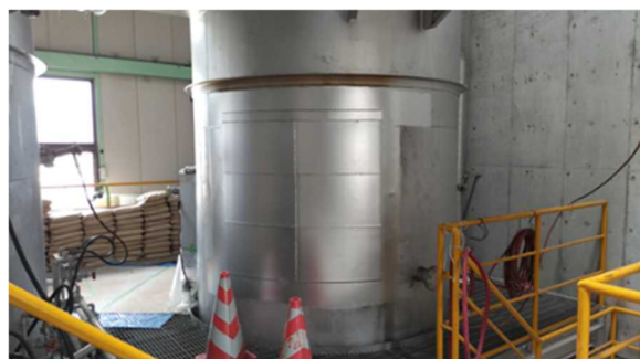
図 5-5-1 高温加熱器撤去後
