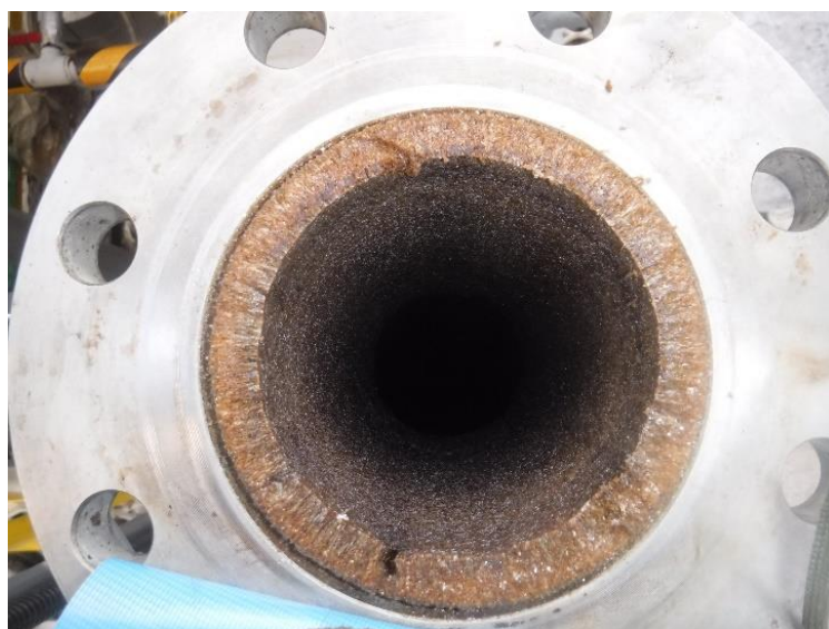
図 5-3-5 対策前の内部状況
