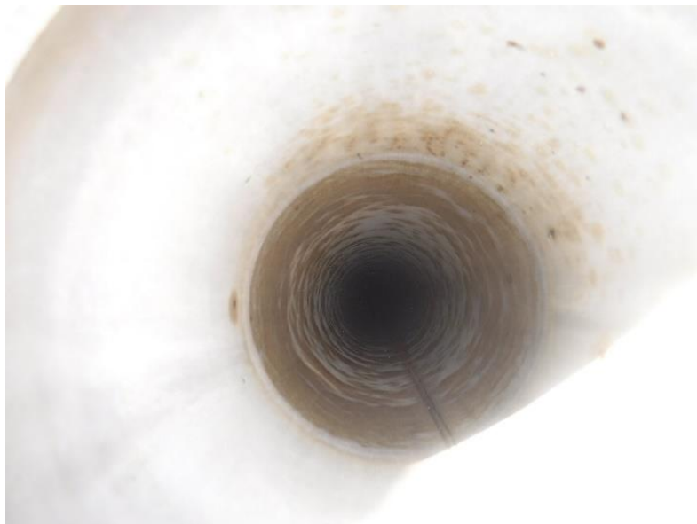
図 5-3-7 対策後の内部状況
