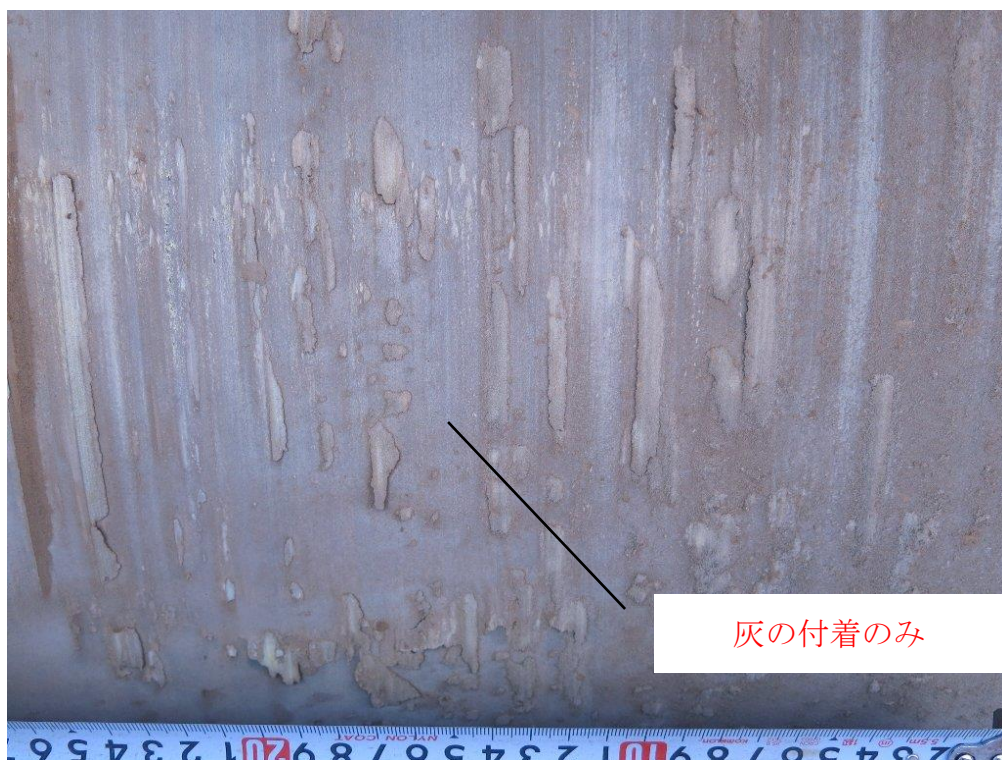
図 3-6-2 (a)改質部での熱分解ガス化改質炉外面の写真
