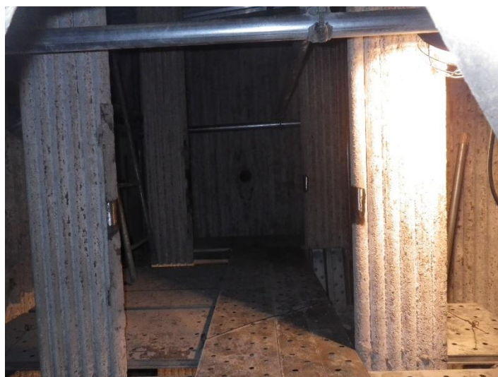
図 3-23 1号炉内確認（2021年11月）
