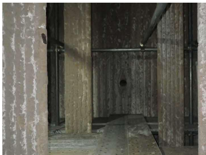
図 3-24 1号炉内確認（2022年11月）
