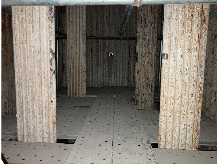
図 3-25 1号炉内確認 (2023 年 12 月)
