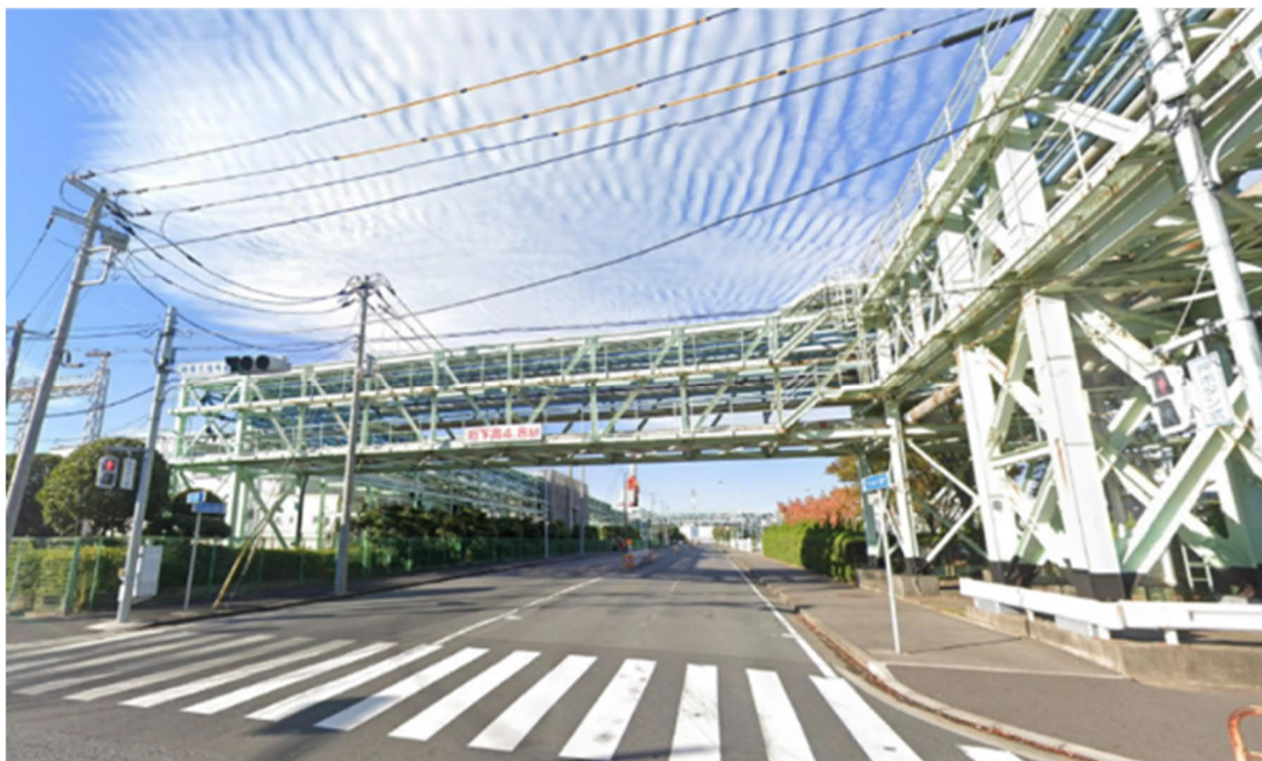
図 4.1-3 京葉ユーティリティ設備外観（上：ボイラ、下：配管ラック）
