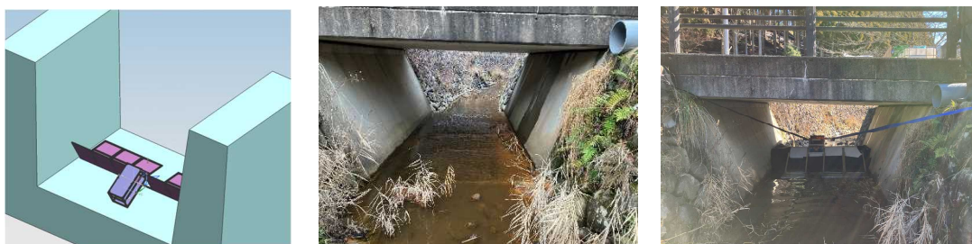
図 32 ピコ水力発電機の設置構想および河川への装置設置前後の様子
