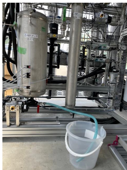
図 2-11 手動でのドレン水抜き出し口設置部分の写真
