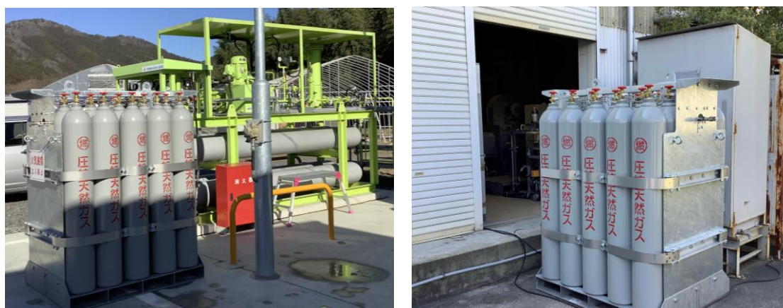
図 2-12 充填中のカードル（左）とエンジン性能試験中の様子（右）
