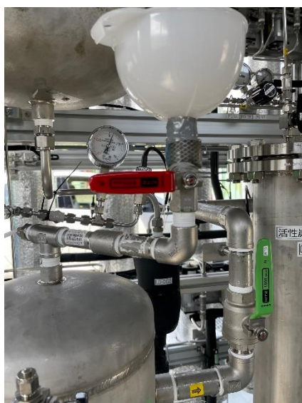
図 2-11 手動でのドレン水抜き出し口設置部分の写真
