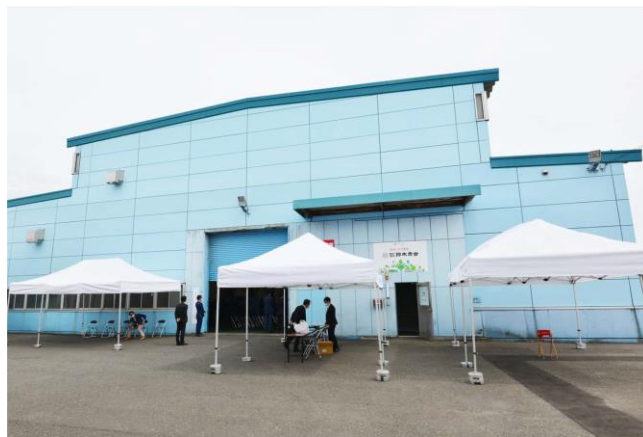
図 II. 1-13 苫小牧プラ・ファクトリーの様子 24)
