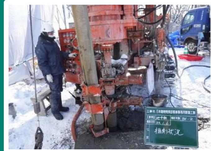
地中熱交換器設置用堀削状況
