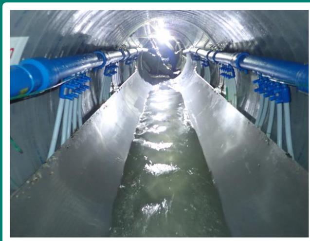
下水熱交換器（採熱管ヘッダー部）
