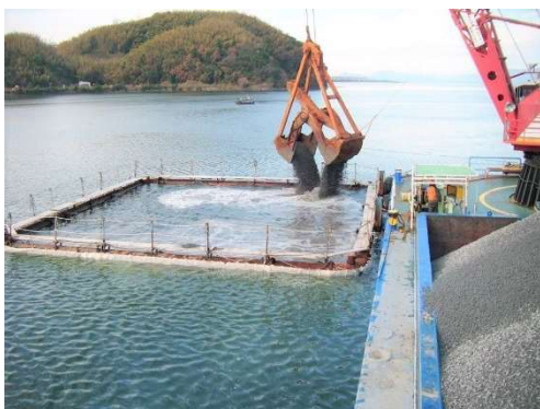
窪地埋め戻し作業
