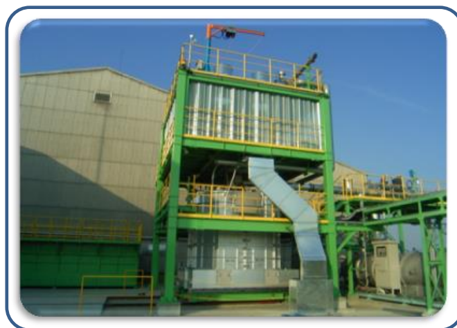
図 1.5.1-3 浄化等処理施設（溶融）の例
