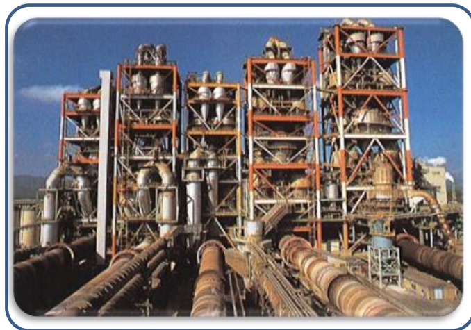
図 1.5.1-4 セメント製造施設の例
