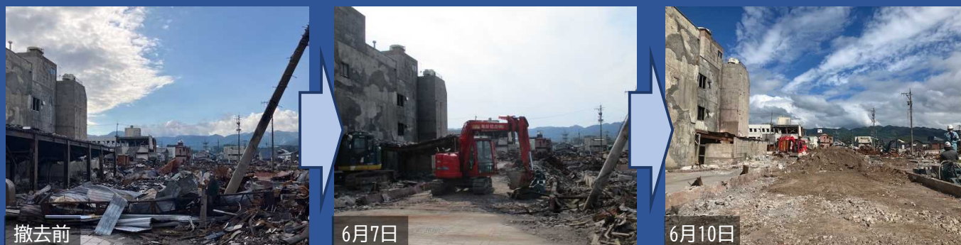
輪島朝市における解体・撤去工事
