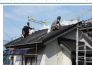
●建物の屋根等の洗浄
