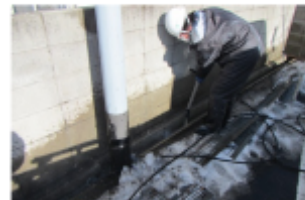
●側溝の汚泥の除去 (提供) 福島市
