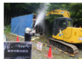
被災家屋等の解体の様子
