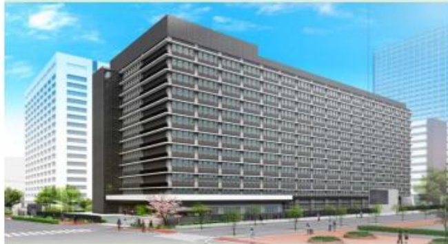
新庁舎外観（地上13階、地下2階）
