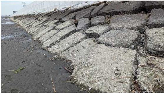
①高潮堤防礎石部分
