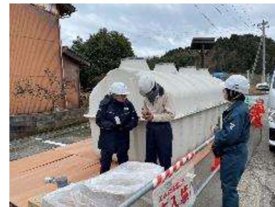
能登町での浄化槽の状況確認
