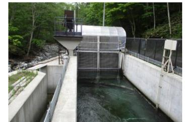
図7.8 沈砂池・除塵機・排砂口
