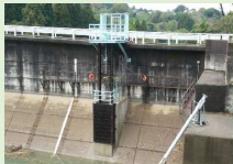
取水口 (水位低下時)
