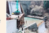
仮設橋脚の設置時の施工風景
