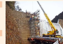
コンクリート削孔工事
