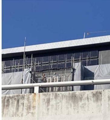
建物壁面への実装工事の様子
