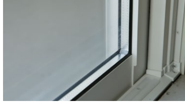
全住戸で外窓交換を実施
