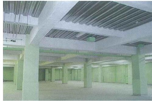
(参考資料) 写真 6-12 けい酸カルシウム板第2種を耐火被覆として使用している例
