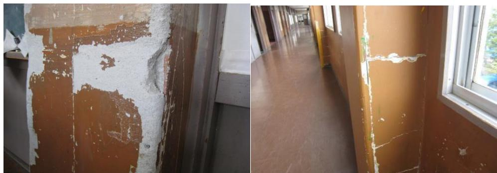
(参考資料) 写真 6-13 鉄骨造校舎 教室・廊下の柱 長年の接触により欠損している
