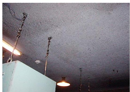
天井、一部に吊りボルト増設の痕あり、一部で剥落箇所あり
