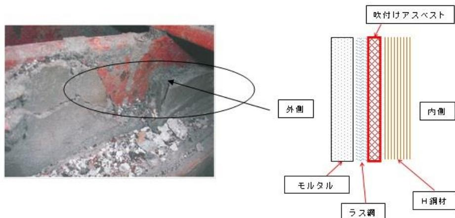
（参考資料）写真6-1 鉄骨造の柱の石綿含有吹付け材
