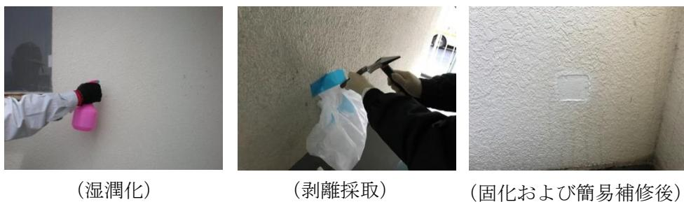
図 I-5-9 サンプリング例（建築用仕上塗材等）
