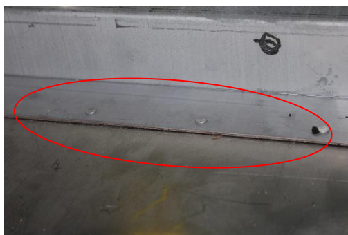
HEPA フィルタ取り付け面
