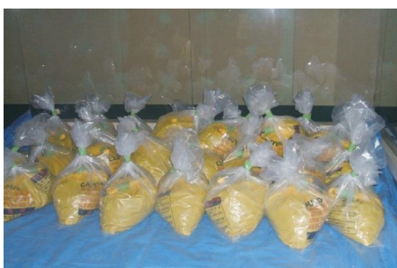
図 4.7.78 除去した石綿廃棄物の保管
