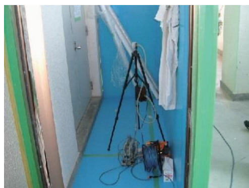
図 4.7.8 同左施工区画 (内部)
