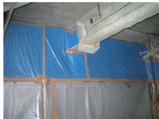
図 4.7.12 壁面の負圧隔離養生例（作業場内側）
