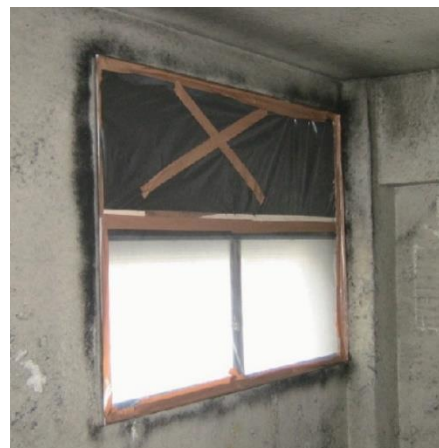
図 4.7.14 窓、換気口の負圧隔離養生例
