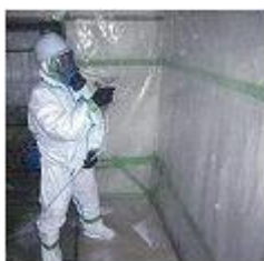
②隔離シートへの散布
