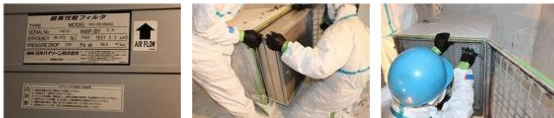
図 4.7.86 フィルタの取り付け
