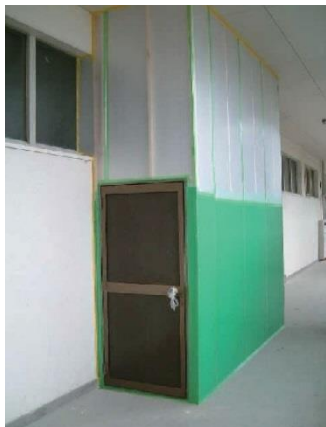
図 4.7.7 教室前廊下の施工区画 (外部側)
