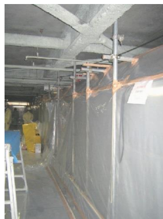
図 4.7.6 同上施工区画 (内部側、右外側が車路)
