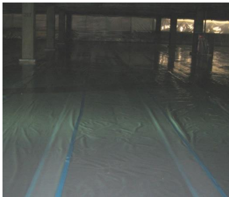
図 4.7.11 床面の負圧隔離養生例（2重張り）
