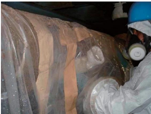
図 4.10.10 石綿除去作業中 2
