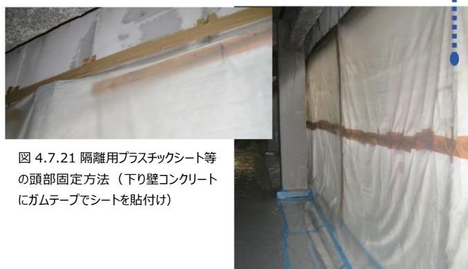
図 4.7.22 開口部の負圧隔離養生（防災シートの内側をプラスチックシート等で養生）
