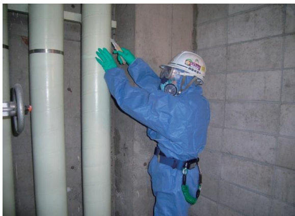
図 4.8.2 保温材被覆撤去
