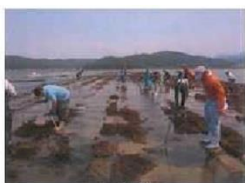
岩盤清掃 (国見地区)
