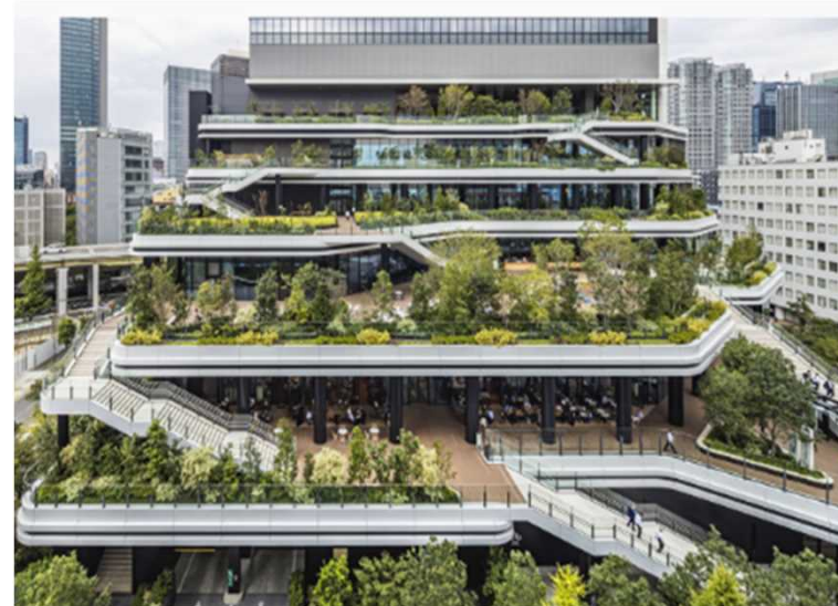
▲スキップテラス外観
