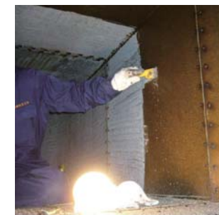
ダクト内の洗浄の様子 [出典:(社)日本空調システムクリーニング協会]
