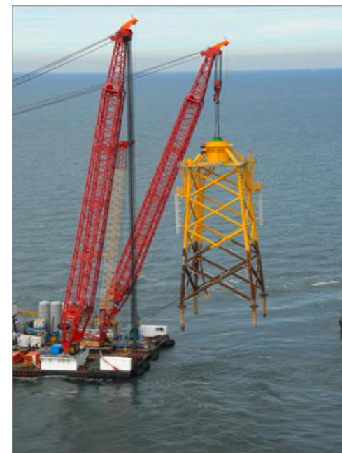
ジャケット式の設置状況
