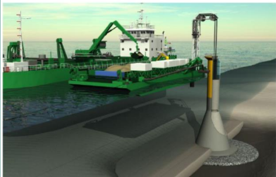
基礎へのバラストの詰め込み
