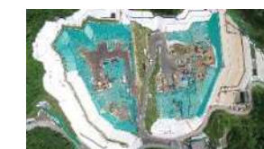
特定廃棄物埋立処分場
