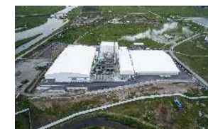
浪江町 仮設焼却施設
