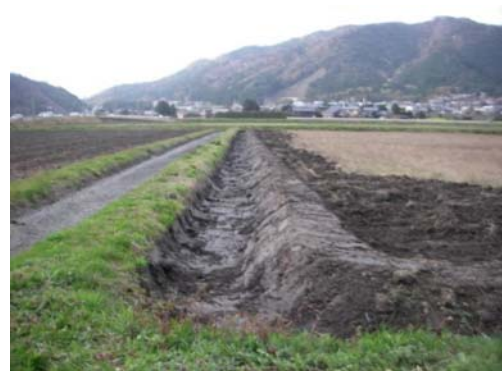
写真 3. 2-4 退避路の設置（施工後）
