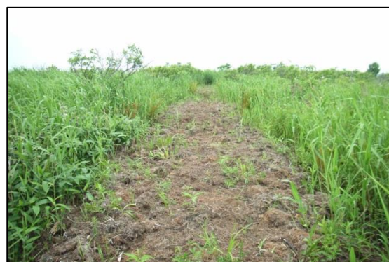
図 4-12 埋め戻し後の水抜き水路 2（2011 年 7 月）
