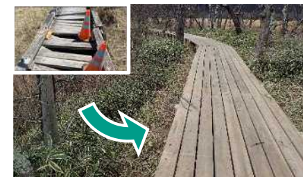
老朽化木道の改修等
