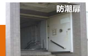
地下鉄出入口の浸水対策
