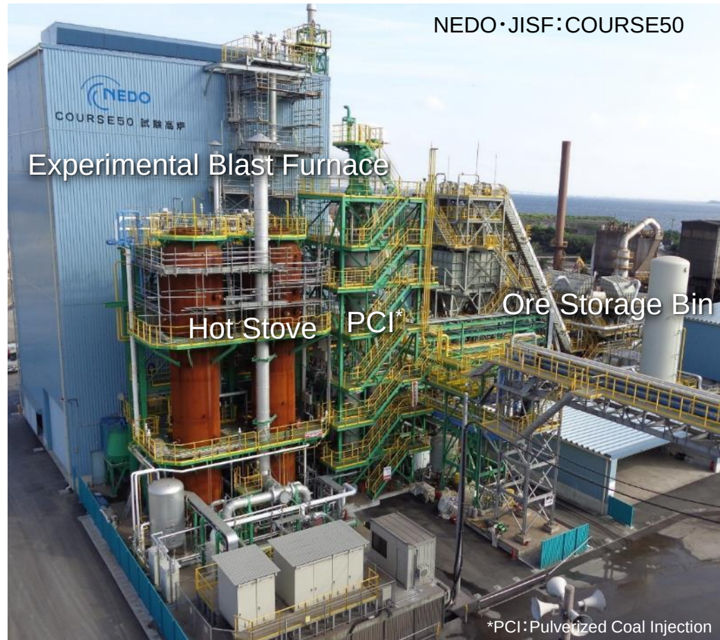
COURSE50 プロジェクト試験高炉
