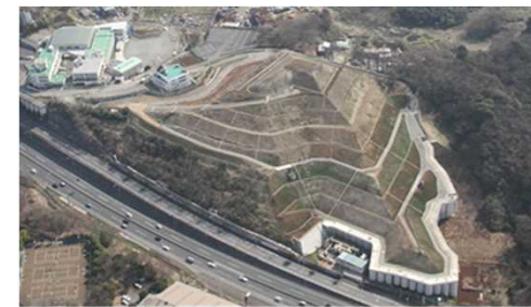
廃棄物崩落、飛散防止対策完了状況
