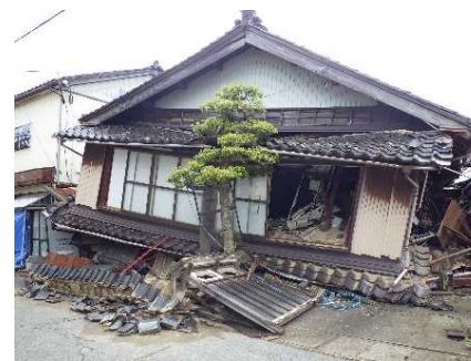
②損壊した家屋等の解体、がれきの収集・運搬及び処分
