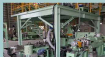
③バイオマスプラスチック製造設備
