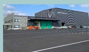
①PETボトル水平リサイクル設備
