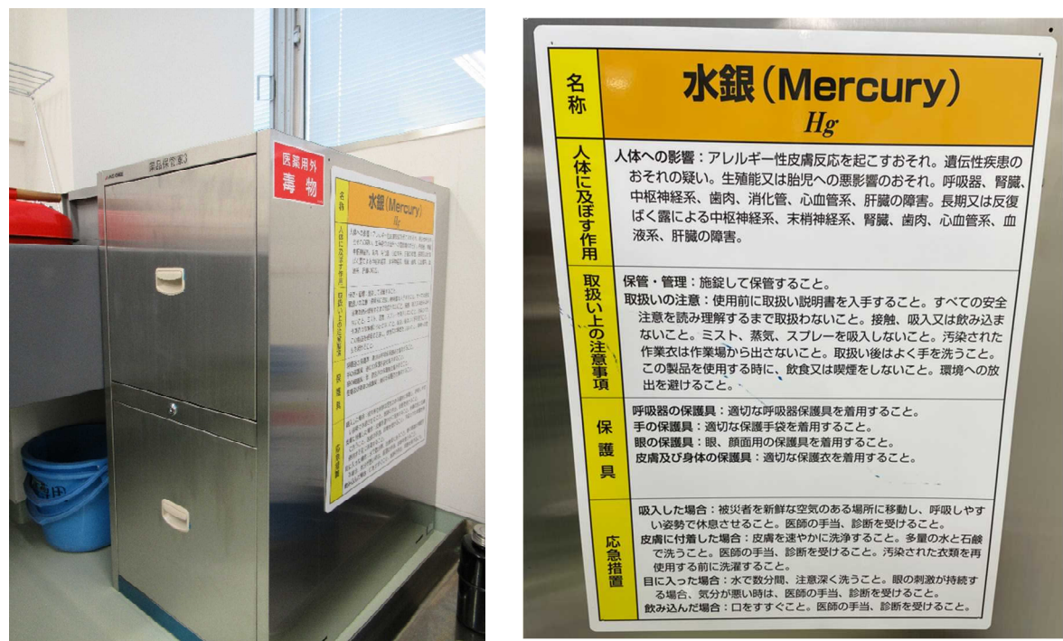
図 12 SUS304 製施錠付き薬品庫及び薬品庫の提示物
