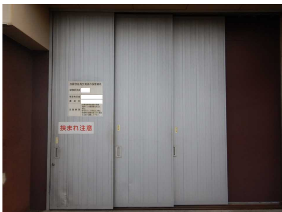
図 9 保管している建屋入口の様子
