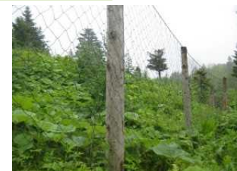
侵入防止柵の設置
