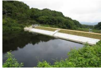
老朽化したため池の全面改修
