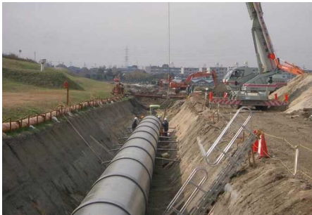
水路のパイプライン化
