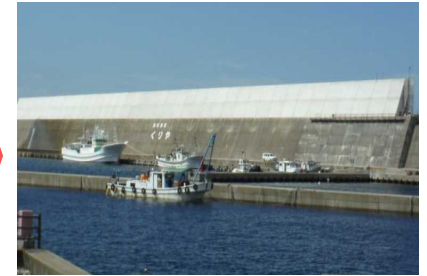
防波堤の嵩上げや消波ブロックの設置により、漁港内への越波を防止
