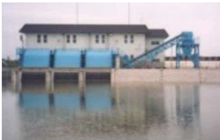
排水機場の整備
