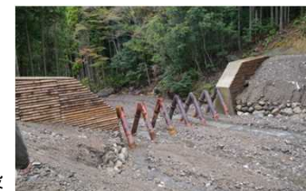
流木捕捉施設
