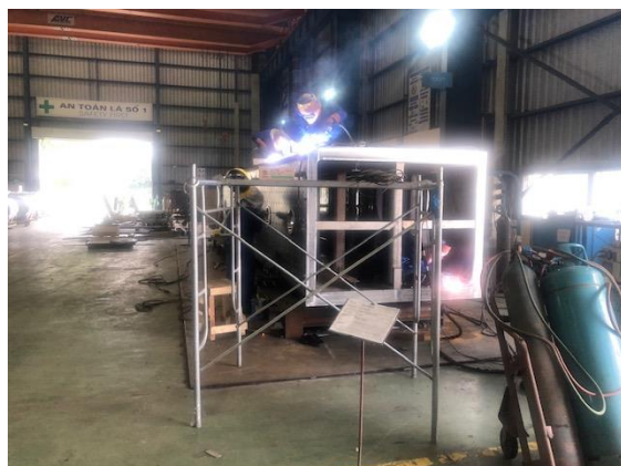
写真２－１－１－６ 溶接作業状況
