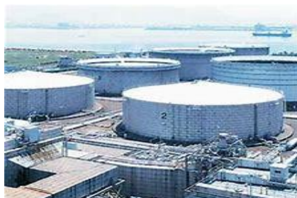
石油貯蔵タンク
