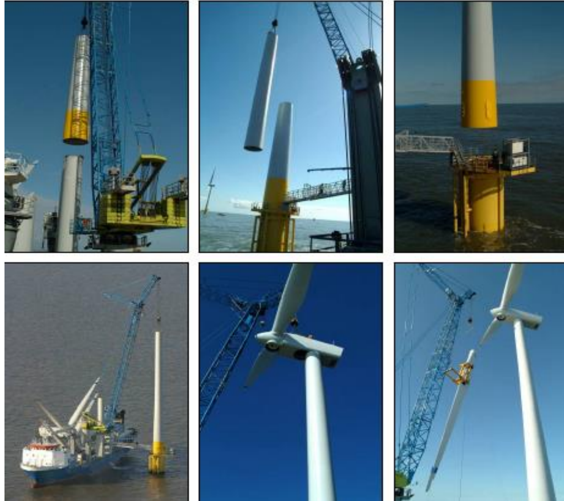
風力発電機の据付作業
