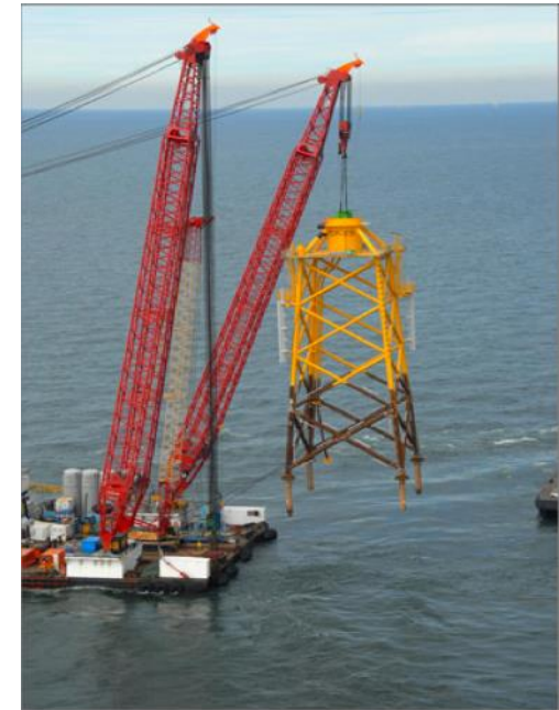
ジャケット式の設置状況
