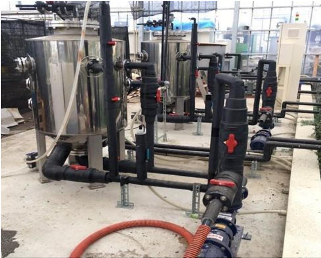
図 4-5 メタン発酵槽（後方）
