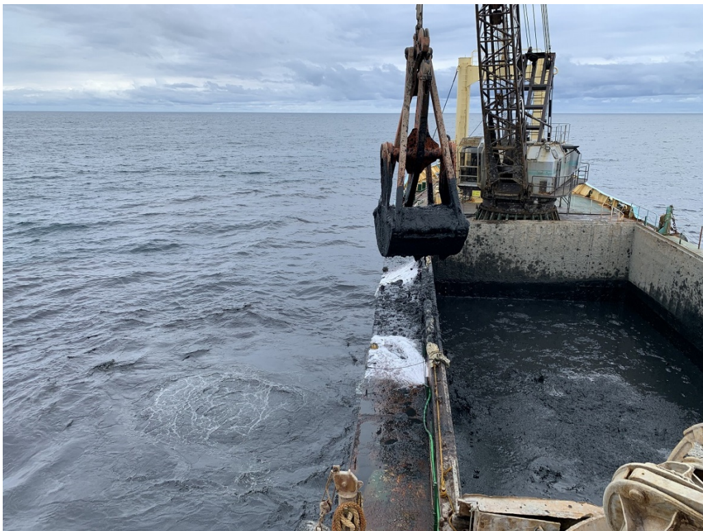
写真-3.5 ガット船による浚渫土砂排出状況
