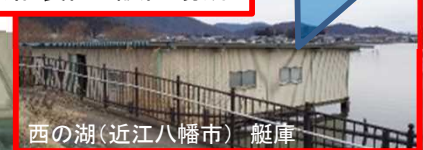
酸素供給装置 設置場所
