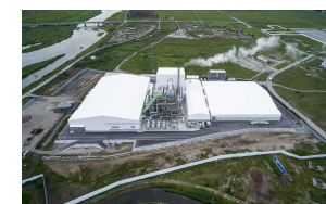
浪江町 仮設焼却施設
