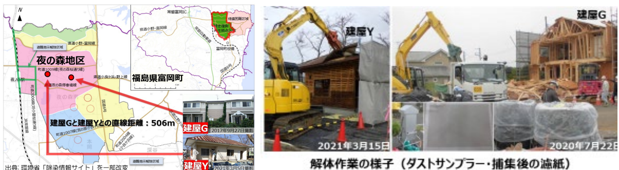
図II-5 解体作業に伴う建屋周辺で発生するダストの調査
