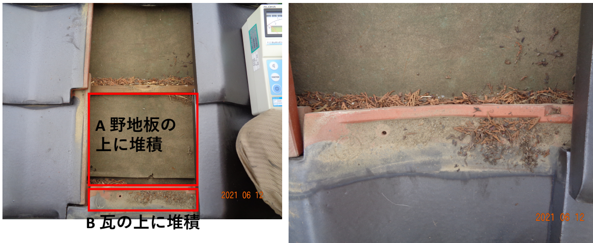
図 IV-4 浪江町住家における瓦屋根内側の堆積物
